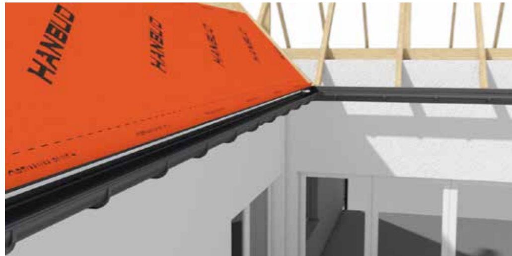
Rys. 6 Rozkładanie membrany na powierzchni połaci.
