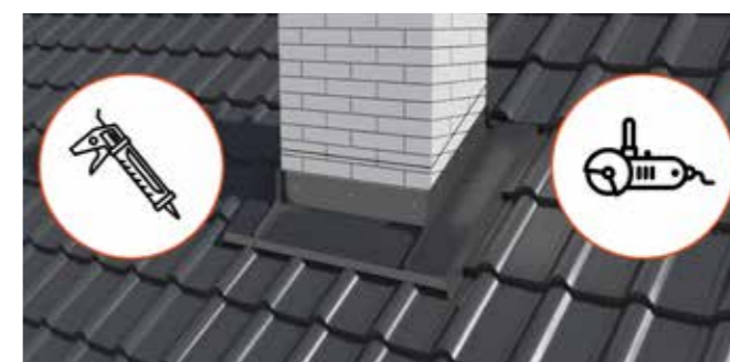
Rys. 21 Nacięcie komina przed montażem obróbek górnych.
